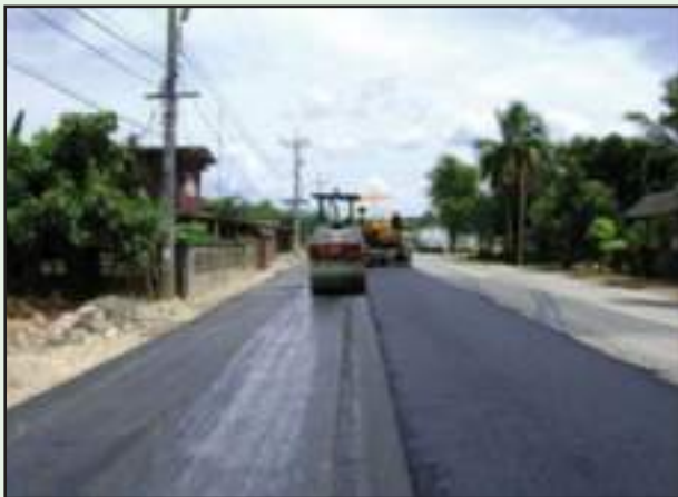
รูปที่ 6-35 การบดทับและแต่งแนวขณะปู
