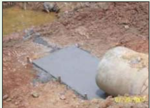
รูปที่ 5-15 การขุดบ่อรวมน้ำ เพื่อระบายน้ำออกจากแนวการวางท่อ
