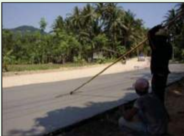
รูปที่ 6-60 แต่งลายที่ผิวหน้าขณะคอนกรีตยังหมาดอยู่
