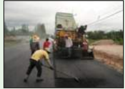
ควบคุมแนวการปู
