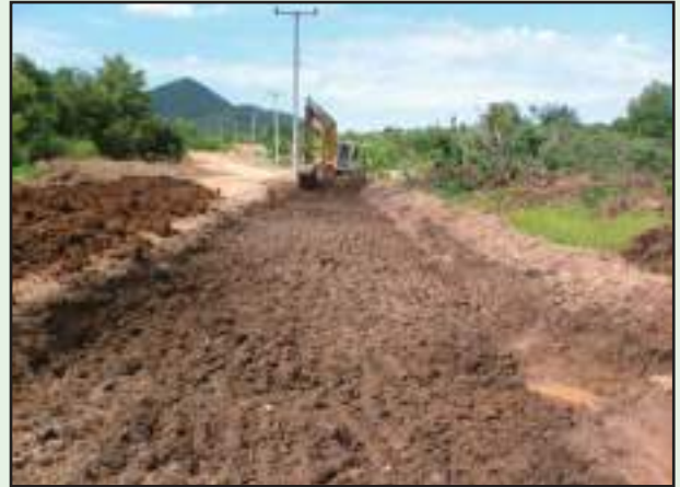
รูปที่ 5-9 ลักษณะดินที่ต้องปรับปรุงก่อนวางท่อ
