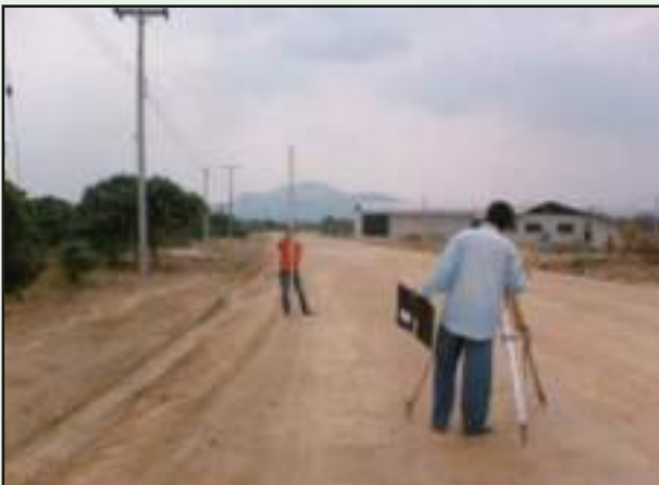
รูปที่ 4-18 ทำการตรวจสอบระดับหลังจากทำการเกรดบดอัดโดยละเอียด (Fine Grade)
