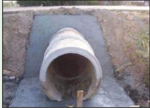
รูปที่ 5-39 การแต่งผิวหน้าคอนกรีตให้เรียบ
