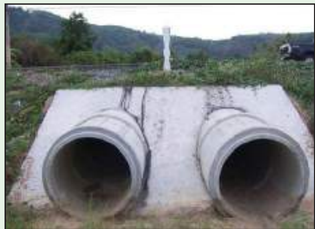
รูปที่ 5-42 หลังจากถอดแบบและปรับระดับดินรอบแผ่นคอนกรีตเรียบร้อยแล้ว ให้ตรวจสอบเพื่อให้แน่ใจว่าไม่มีการกีดขวางของน้ำรอบบริเวณแผ่นคอนกรีต
