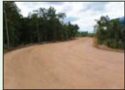
รูปที่ 4-40 ชั้นรองพื้นทางที่แล้วเสร็จต้องมีความเรียบและได้ระดับตามแบบแปลน
