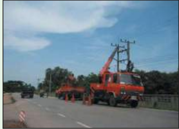
รูปที่ 2 - 2 การดำเนินการย้ายสาธารณูปโภคออกจากเขตก่อสร้าง
