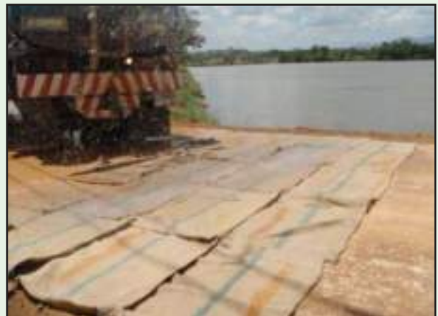
รูปที่ 6-67 การบ่มคอนกรีตด้วยกระสอบป่าน
