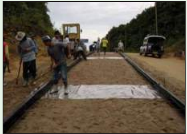
รูปที่ 6-54 ทุกรอยต่อต้องวางแผ่นรองกันชื้น
