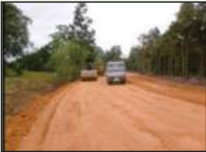
รูปที่ 4-38 การคลุกเคล้าผสมและบดอัดชั้นรองพื้นทาง
