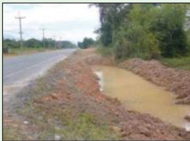
รูปที่ 4-13 บริเวณที่มีน้ำขัง ก่อนถมคันทาง ต้องสูบน้ำทิ้งและตากให้แห้ง
