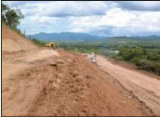
รูปที่ 4-30 การขุดตัดเพื่อก่อสร้างคันทางให้ได้ระดับ
