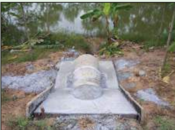
รูปที่ 5-42 หลังจากถอดแบบและปรับระดับดินรอบแผ่นคอนกรีตเรียบร้อยแล้ว ให้ตรวจสอบเพื่อให้แน่ใจว่าไม่มีการกีดขวางของน้ำรอบบริเวณแผ่นคอนกรีต
