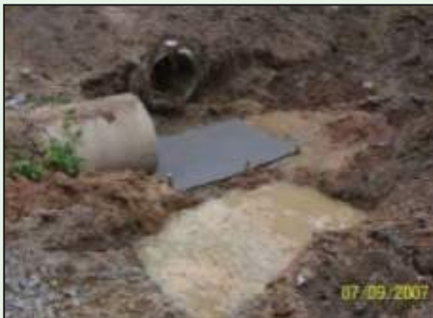
รูปที่ 5-15 การขุดบ่อรวมน้ำ เพื่อระบายน้ำออกจากแนวการวางท่อ
