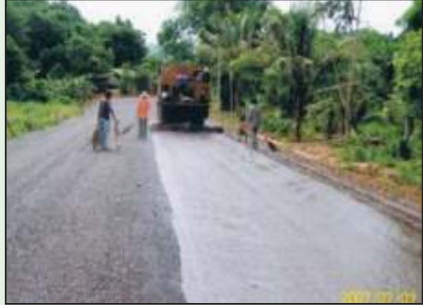
รูปที่ 6-44 การฉาบผิวสเลอรี่ซีล
