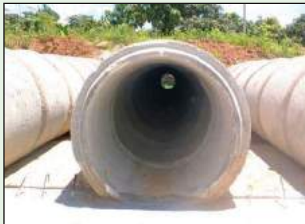
รูปที่ 5-37 การทดสอบหน้าท่ออาจทำในขั้นตอนการเทคอนกรีตหยาบร่องท่อก็ได้
