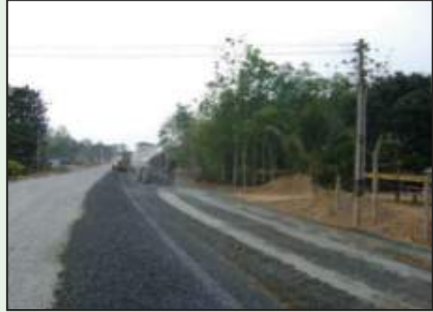
รูปที่ 4-46 การผสมและบดอัดหินคลุก
