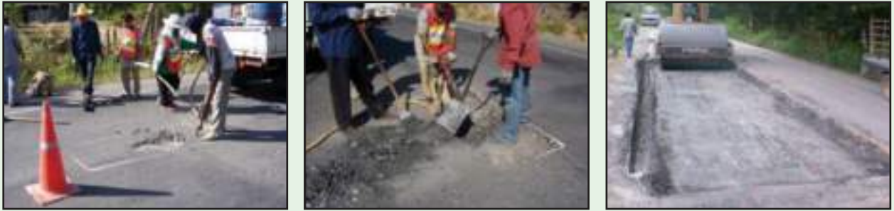
รูปที่ 6-24 แต่งพื้นที่เสียหายและปะซ่อมเสริมให้ได้ระดับ
