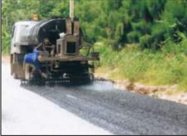
รูปที่ 6-43 พ่นยางเคลือบผิวชั้นแรก (Fog Spray)
