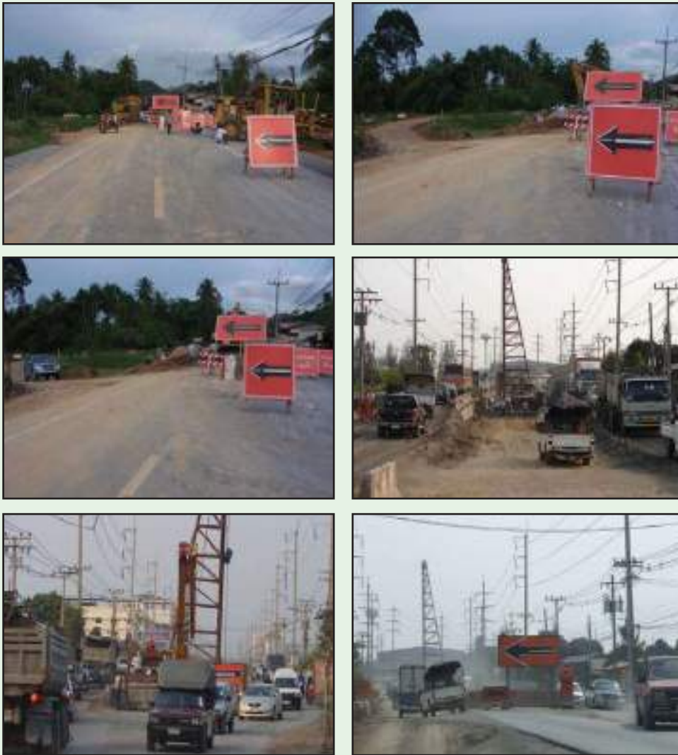
รูปที่ 8-5 การเบี่ยงการจราจร กรณีงานก่อสร้างทางและสะพานเขตชุมชน
