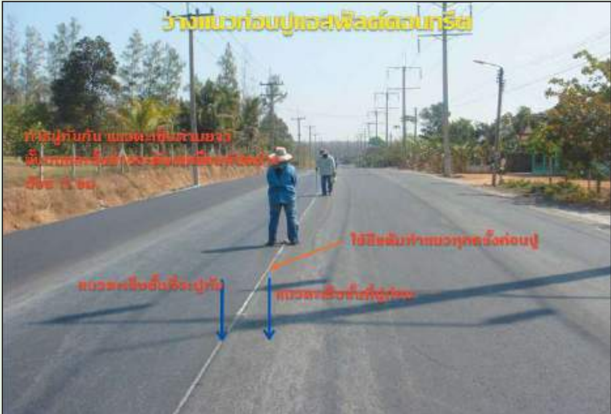
รูปที่ 6-29 แสดงการวางแผนท่อนปูแอสฟัลต์คอนกรีตชั้นถัดไป
