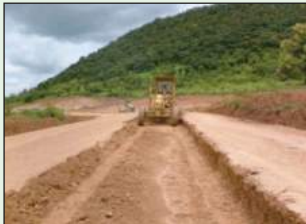
รูปที่ 4-44 ความแน่นไม่ผ่านเกณฑ์ และค่า O.M.C. ไม่อยู่ในช่วง \pm 3\% ให้รี้อแล้วบดอัดใหม่
