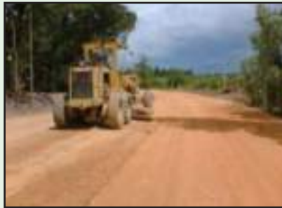
รูปที่ 4-39 การเกรดบดอัดโดยละเอียด (Fine Grade)
