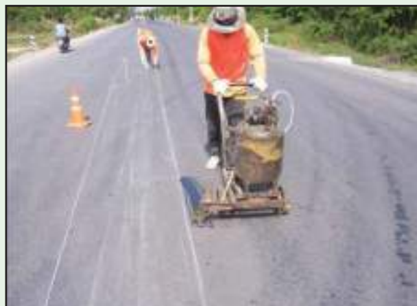
รูปที่ 7-9 ทำการ Primer ด้วยผลิตภัณฑ์ของผู้ผลิตสี
