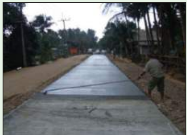
รูปที่ 6-60 แต่งลายที่ผิวหน้าขณะคอนกรีตยังหมาดอยู่
