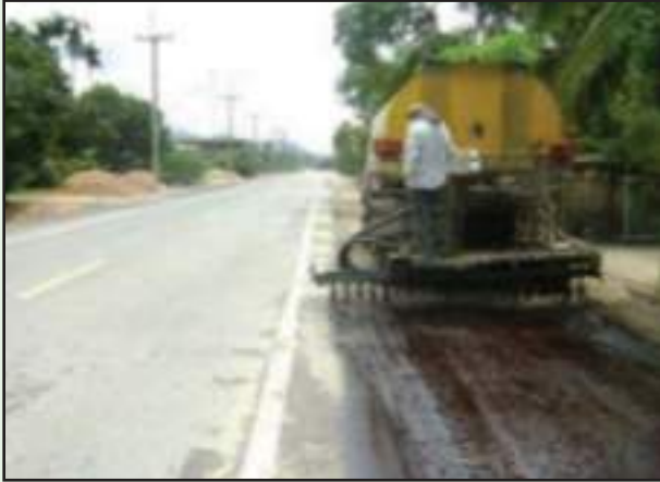
รูปที่ 6-5 เครื่องท้ายควบคุมแรงดันยาง
