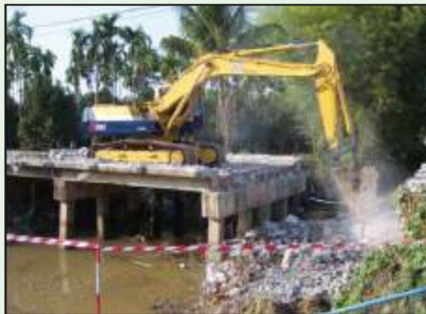
รูปที่ 5-21 การกั้นขอบเขต เพื่อทำการรื้อถอนโครงสร้างเดิม
