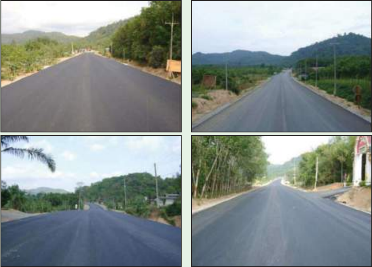
รูปที่ 6-39 ผิวทางที่ก่อสร้างแล้วเสร็จ จะต้องเรียบได้ระดับและรูปแบบ
