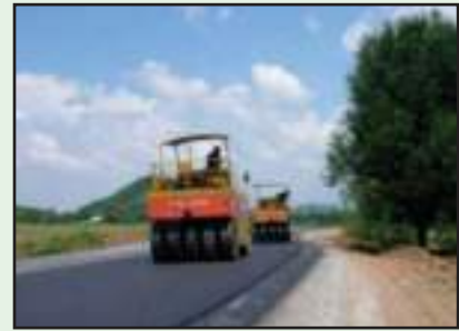
รูปที่ 6-36 การบดทับเริ่มจากบดรอยต่อก่อนและการบดทับด้วยรถบดล้อยาง
