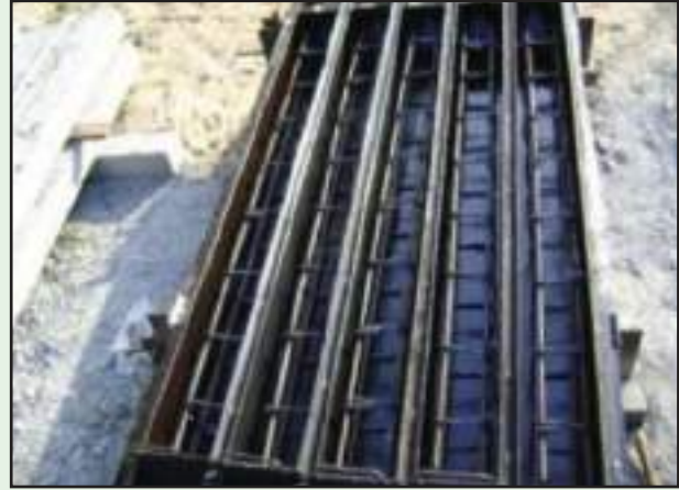
ตรวจสอบแบบหล่อ
