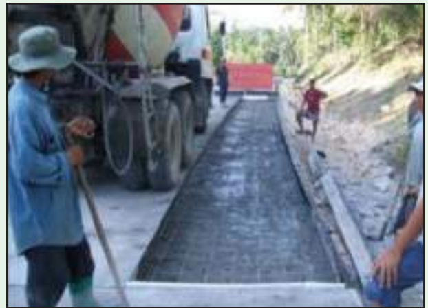
รูปที่ 6-57 เทคอนกรีตปรับเกลี่ยพร้อมวางเหล็กตะแกรงก่อนเทคอนกรีตทับบนเหล็ก
