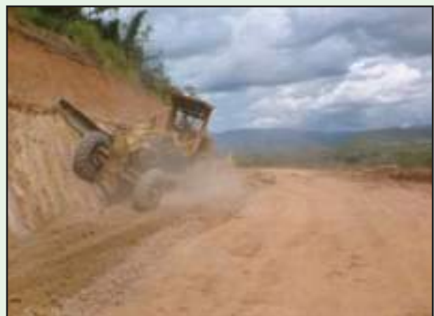
รูปที่ 4-28 การปรับแต่ง Back Slope
