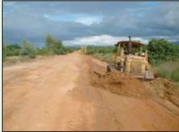
รูปที่ 4-14 การรื้อวัสดุที่ไม่ได้มาตรฐานออก
